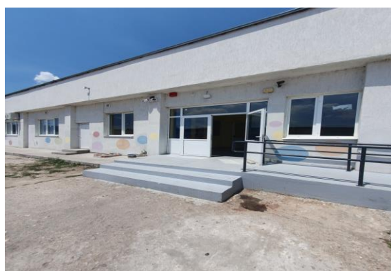
Вход на сигурната зона, изградена в 10-то хале
