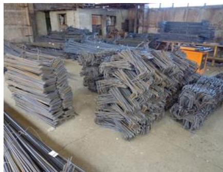
Цех за арматури
